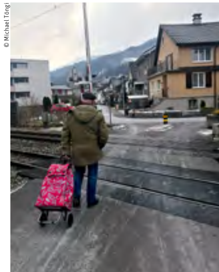
Bahnübergang Wegmat: Bindeglied zwischen Luzern, Horw, Kriens und Hergiswil.
