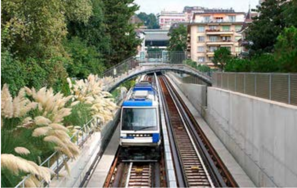
Die gesuchte Linie verläuft grösstenteils unterirdisch, gerade mal 300 Meter davon sind überirdisch angelegt.
