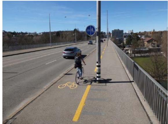
Trennung mittels unterbrochener Linie entlang stark befahrener Strasse. Weil die Bodenmarkierung von den Velofahrenden leicht – auch unbeabsichtigt – überfahren und umgekehrt auch überschritten werden kann, können trotz Verkehrstrennung Mischverkehrssituationen entstehen.
