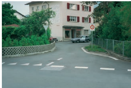
Torelement zu Beginn der Tempo-30-Zone
