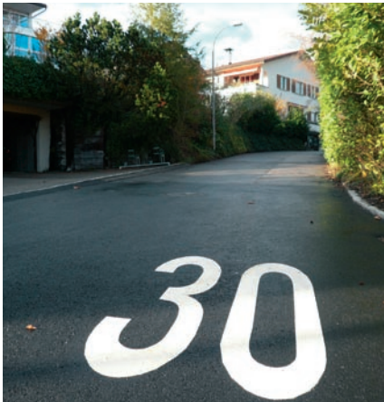
Wiederholt Tempo-30-Signete auf der Fahrbahn
