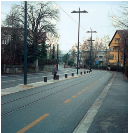
Verkehrsstreifen in der Fahrbahnmitte
